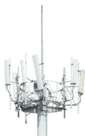
Stationsbase 5G通讯基站
